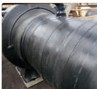
Izolacja połączeń spawanych na zaworze DN 1000
