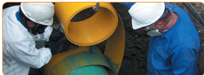
Instalacja rękawa naprawczego Clock Spring
