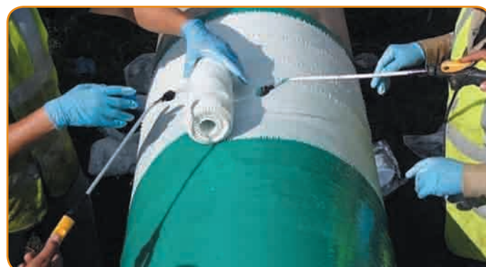
Aplikacja systemu Syntho-Glass XT na prostym odcinku rurociągu
