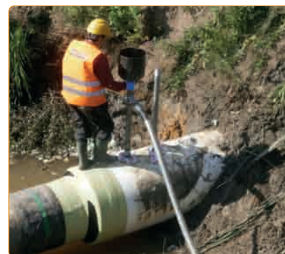
Wypełnienie rury ochronnej masą „ANTICOR Syntetix® CF”
