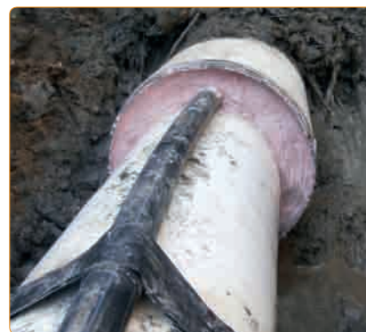
Masa „ANTICOR Syntetix® Mastic” po aplikacji
