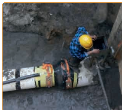
Wypełnienie rury ochronnej masą „ANTICOR Syntetix® CF”
