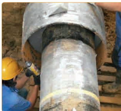
Korek stopujący w systemie „ANTICOR CC”
