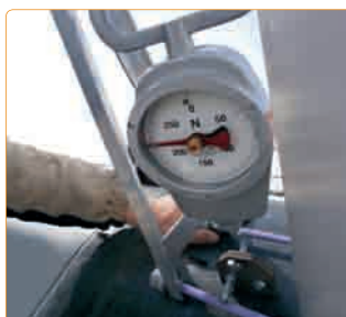
Test przyczepności rękawa „ANTICORRay ® WSS60”
