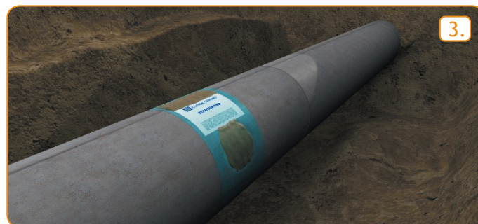
Aplikacja adhezyjnego primeru
