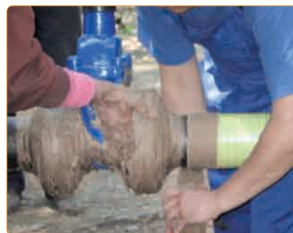
Izolowanie połączenia kotnierzowego oraz zasuwy
