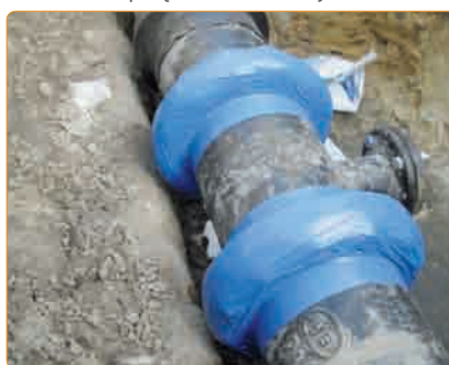
Zaizolowane połączenia kotnierzowe
