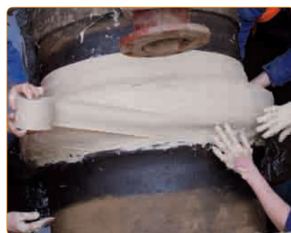
Izolowanie połączenia kotnierzowego
