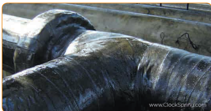
Wzmocnienie gazociągu systemem DiamondWrap
