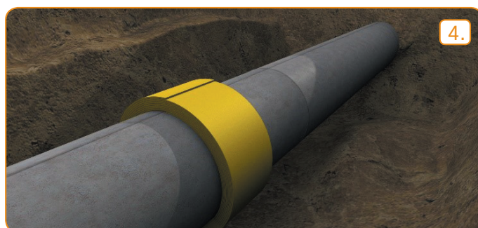
Instalacja rękawa naprawczego Clock Spring
