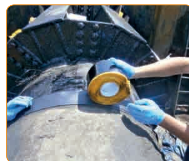
Naprawa uszkodzeń powłoki bitumicznej na rurze DN800
