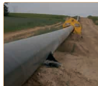
Rurociąg liniowy DN 700 izolowany rękawem „ANTICORRay ® WSS60”
