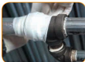
Zabezpieczenia miejsca wycieku systemem Syntho-Glass UP
