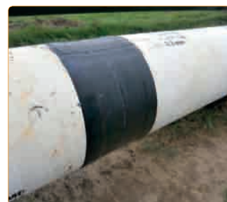
Izolacja połączenia spawanego na rurze z izolacją 3LPP
