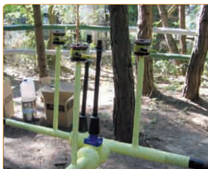
Zaizolowany układ zaporowo-upustowy
