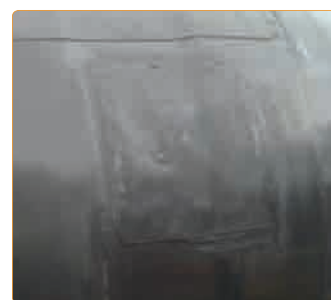
Naprawa uszkodzenia zestawem naprawczym „ANTICORRay® REP”
