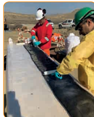
Nasączenie włókna węglowego żywicą epoksydową
