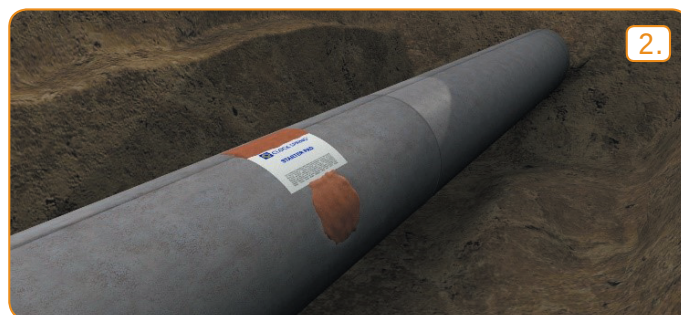
Wypełnienie defektu dedykowaną masą
