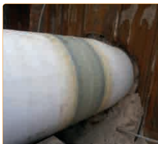
Rękaw „ANTICORRay ® WSS60” wzmocniony laminatem
