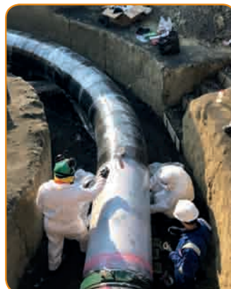
Aplikacja systemu DiamondWrap podczas prac na gazociągu
