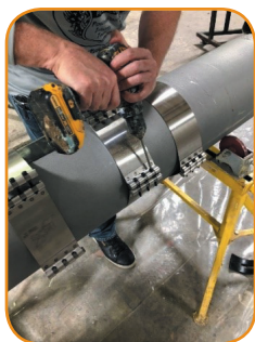
Instalacja opaski na rurociągu
