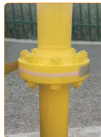
Naziemna izolacja połączenia kotłowego
