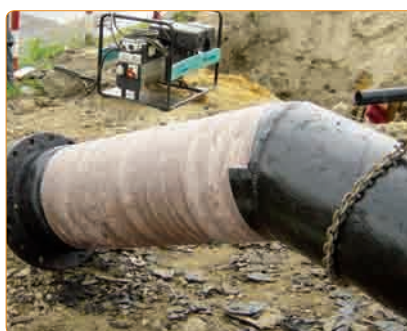
Przykład izolowania calizny rury
