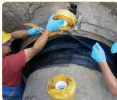
Naprawa uszkodzeń powłoki bitumicznej na rurze DN800
