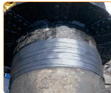
Naprawa uszkodzeń powłoki bitumicznej na rurze DN800
