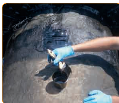
Naprawa uszkodzeń powłoki bitumicznej na rurze DN800
