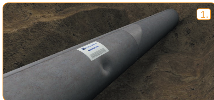
Lokalizacja defektu rurociągu
