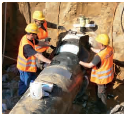
Nakładanie rękawa termokurczliwego (system „ANTICOR CC”)
