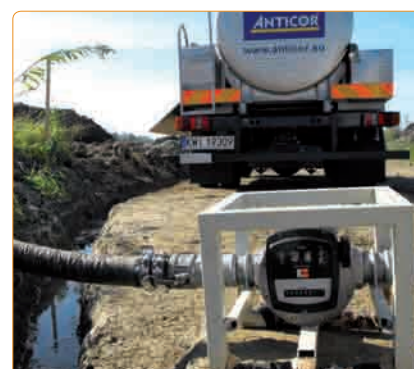
Aplikacja masy „ANTICOR Syntetix® CF” - zdjęcie licznika
