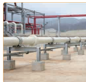
Rurociąg na podporach stalowych
