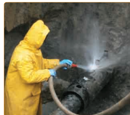
Przygotowanie przestrzeni międzyrurowej przed aplikacją
