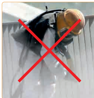
Konwencjonalna metoda obróbki strumieniowo-ściernej.
